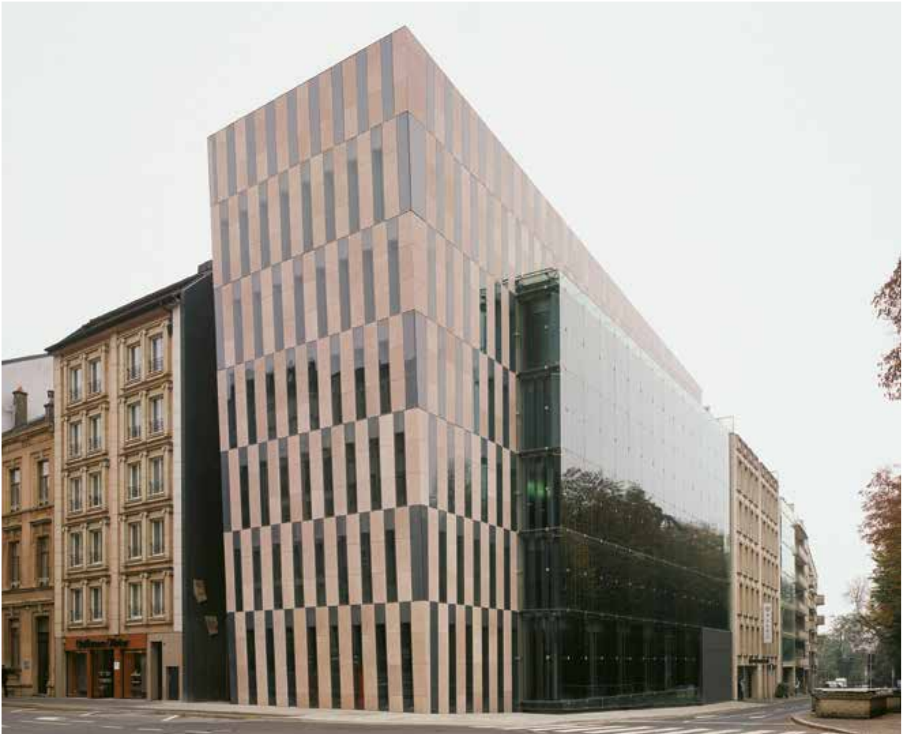
Le bâtiment Monterey
