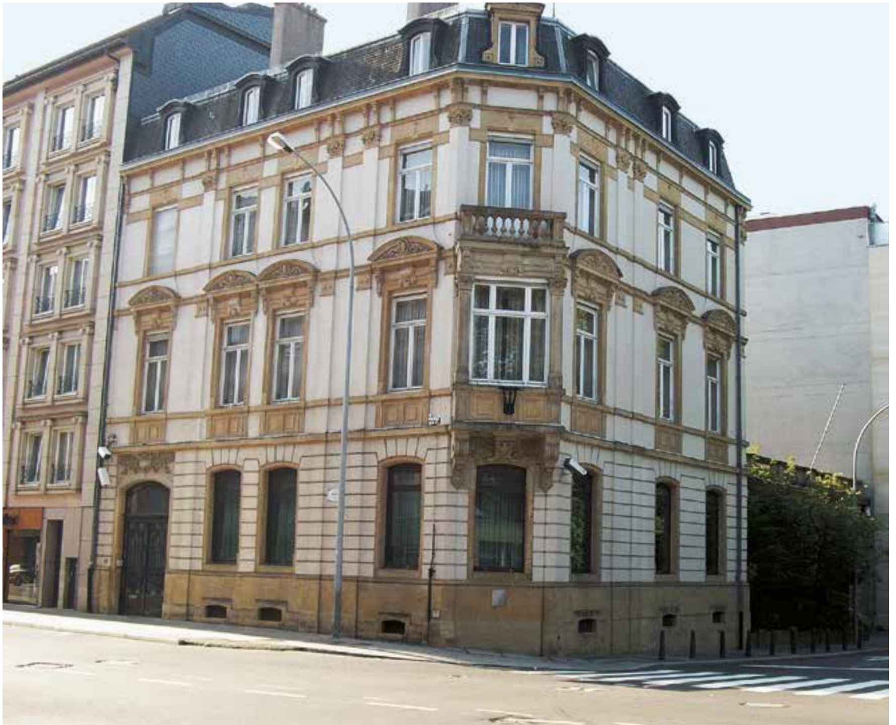
Le bâtiment Prince Henri
