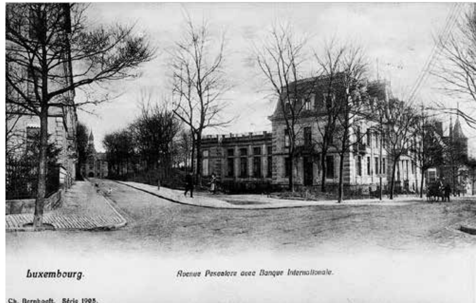
Le siège de la Banque Internationale. Carte postale de Charles Bernhoeft de la Série 1905 (date inconnue). A remarquer : la grande terrasse sur l'arrière-bâtiment (Source : Collection des cartes postales de la Bibliothèque Nationale, Luxembourg)
